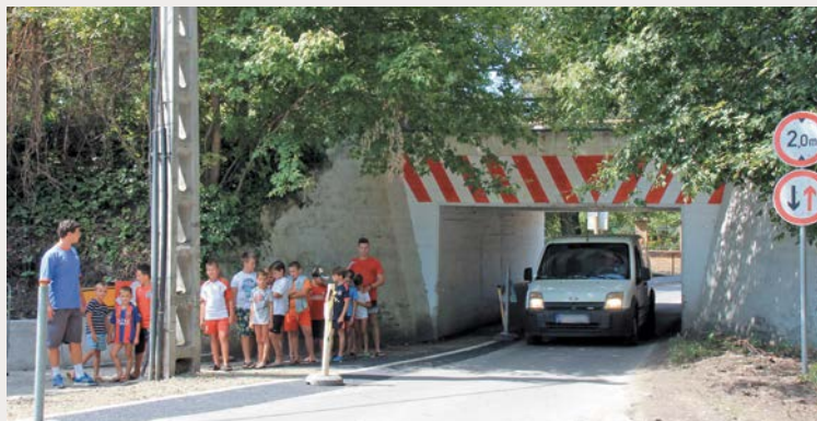
Az alagútnál elvégzett munkálatok után biztonságosabbá vált a közlekedés ezen a forgalmas szakaszon
