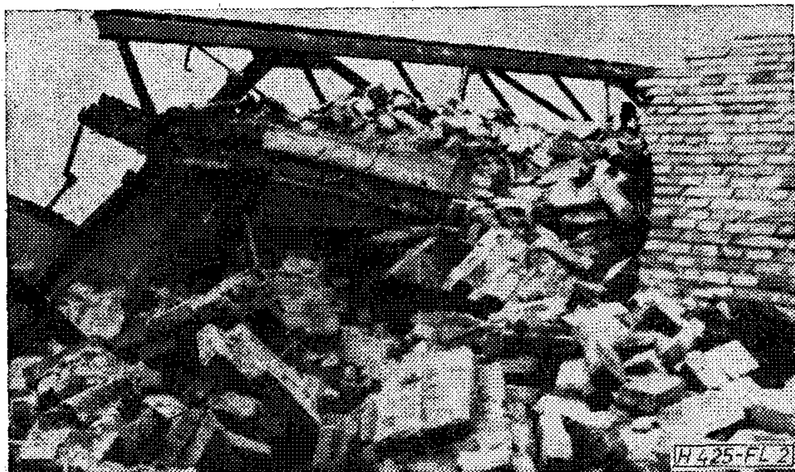
2. ábra. A lakihegyi adóállomás épülete romokban
