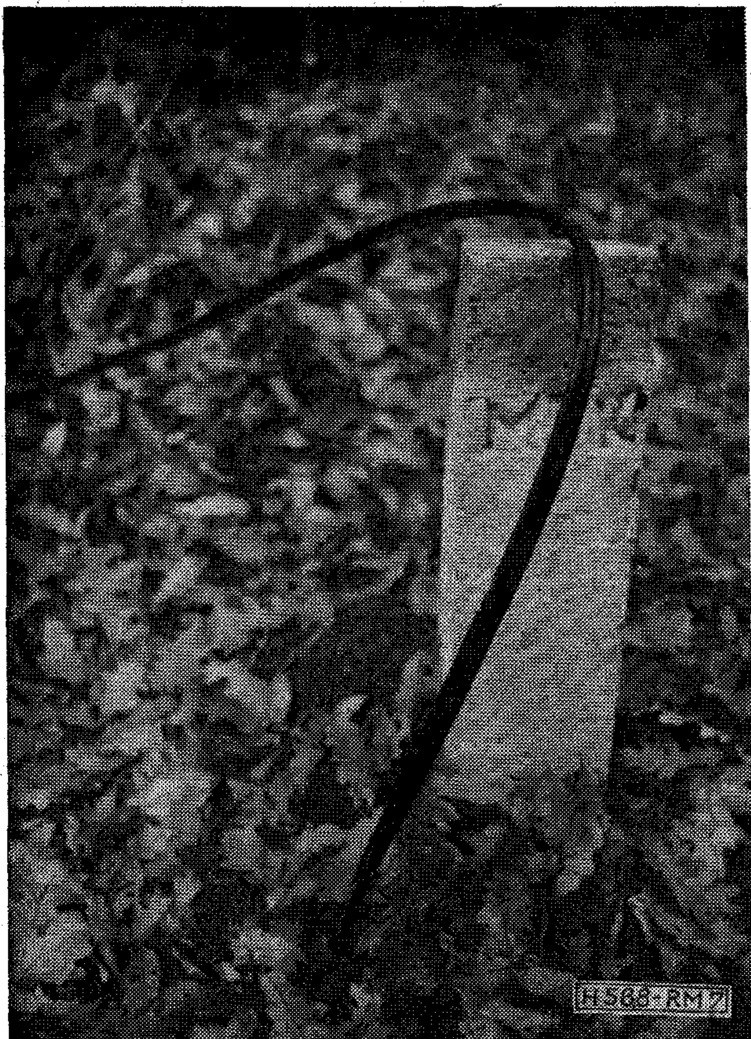
7. ábra. Kötésjelző kő a nyomvonalon
