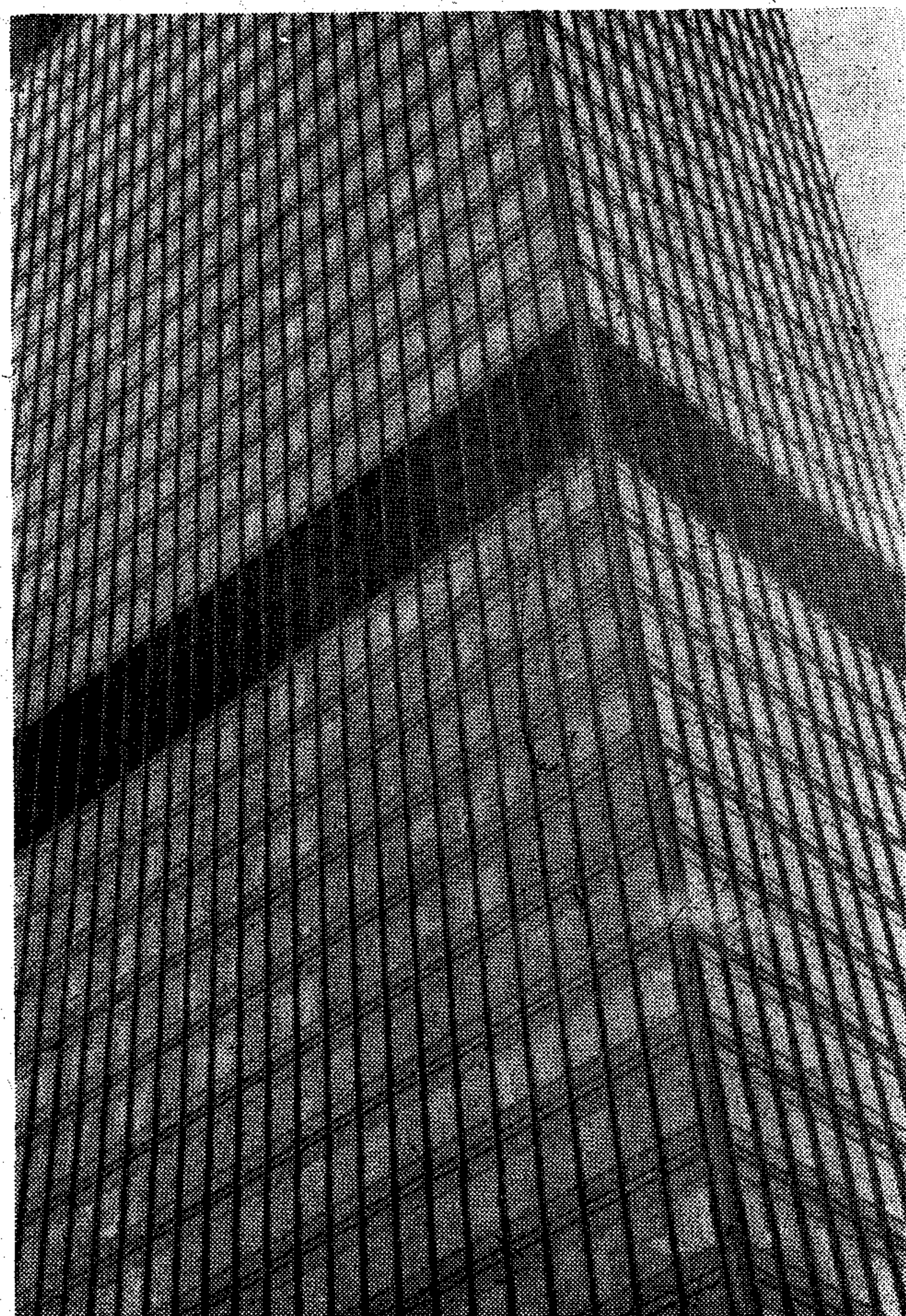
1. ábra. Az acélvázazs épület teljes árnyékolást jelent. Itt nélkülözhetetlen a kábeles televízió
