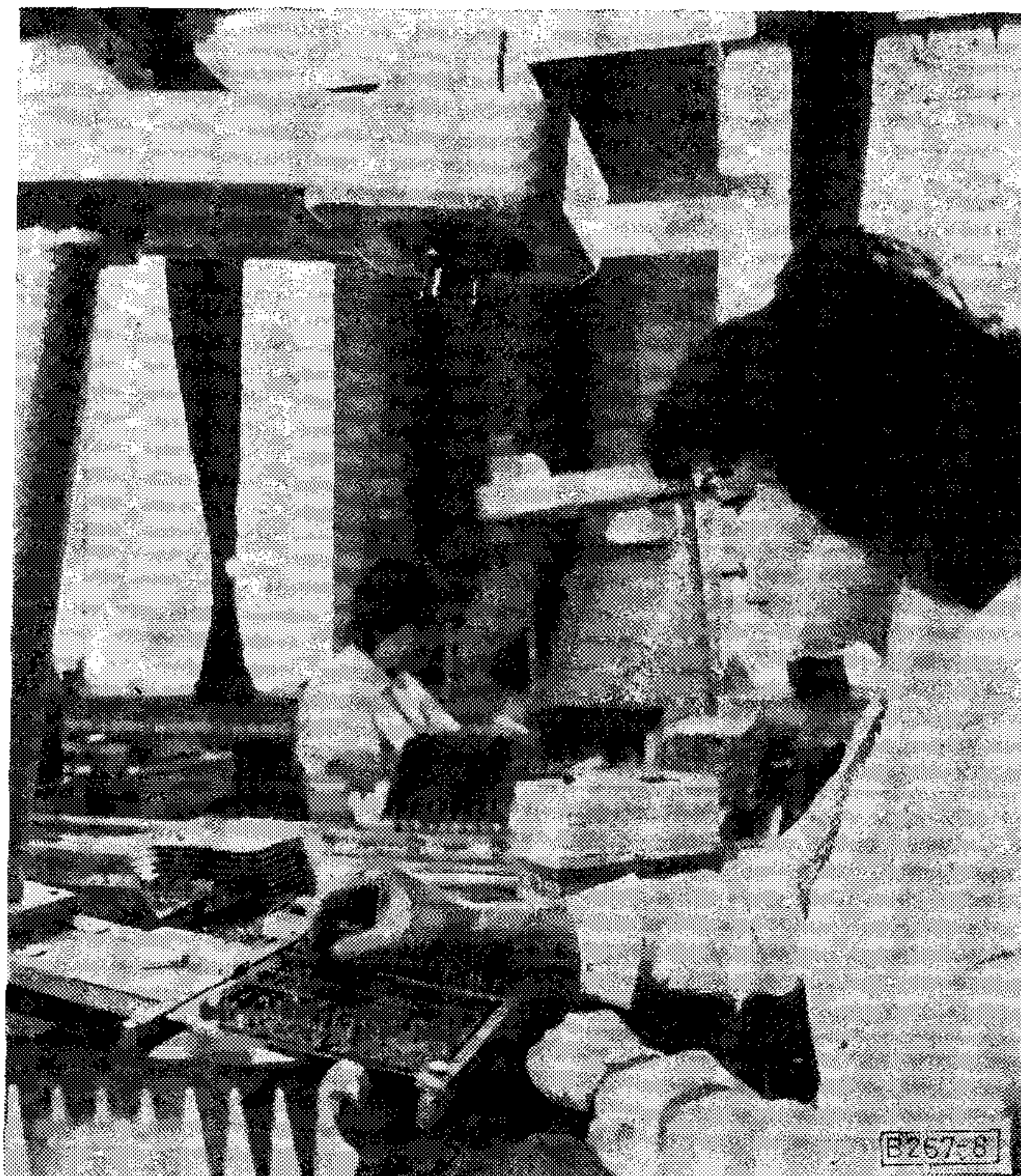
8. ábra. Programvezérelt fényponttal irányított elembeültető félautomata
