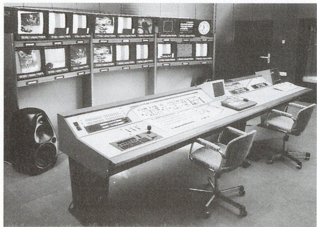
1. ábra. A stúdiók rendezői munkahelye a képmixer és a digitális effektberendezés, valamint az editor vezérlőpultjával. Háttérben a karaktergenerátor klaviatúrája.
