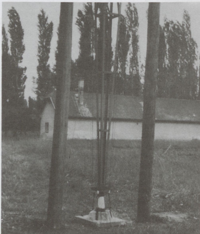
4. fénykép. A javasolt új ún. „szoknyás” kialakítás a modell antennán
