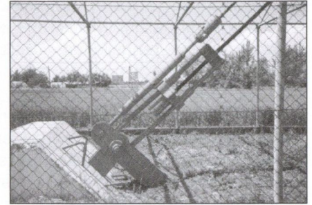
10. ábra Felső két lehorgonyzó kötel feszítő szerelvénye
