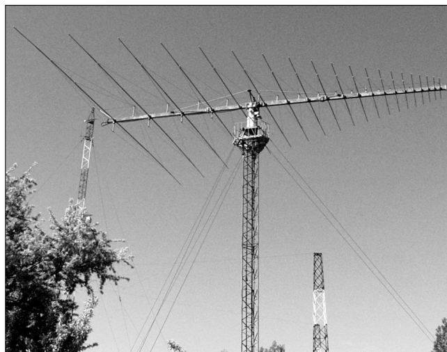
5. ábra Thomcast gyártmányú log-per antenna
