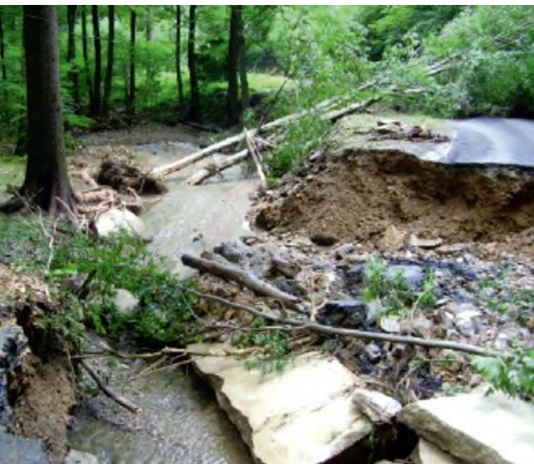
3. kép Villámárhullám hatására elmosott átereszt az erdészeti úton
