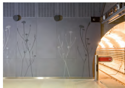
A 4-es metró szál-erősített betonszerkezete
