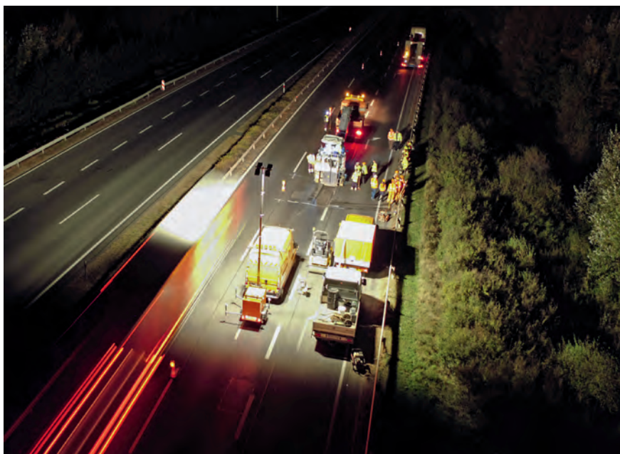
Éjszakai burkolatjavítás az M1 autópályán [forrás: MK NZrt.]
