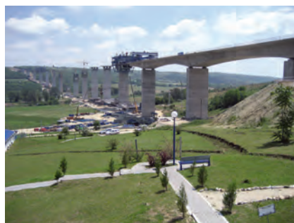
Köröshegyi völgyhíd, építés közbeni állapot
