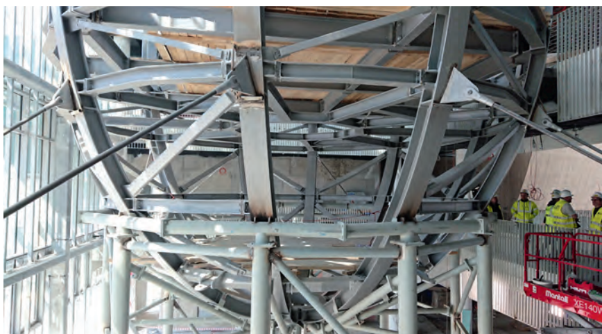
Szerelési állvány és szerelés – helyszíni fotó
