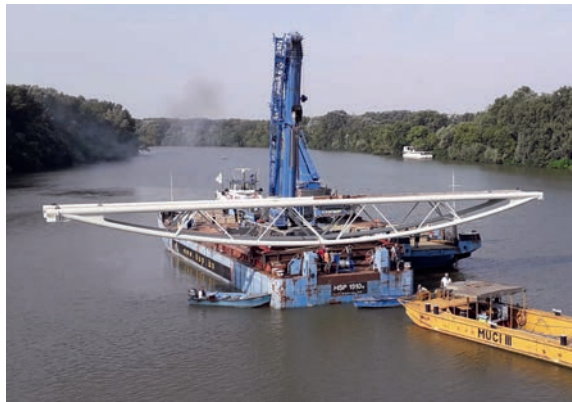
A Tisza-híd szélső nyílásának szállítása a szerelőtérrel a csárda melletti támaszhoz
