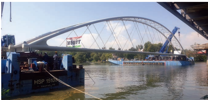
Tisza-híd: az első mederelem úsztatásának megkezdése
