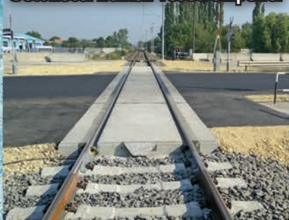
Betonacél nélküli vasúti sínpanel
