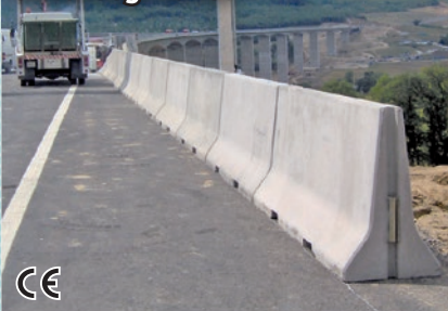
New Jersey típusú közúti biztonsági korlát
