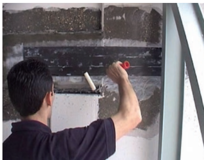
Stadionlelátó megerősítése Carboplate lamellákkal – Nyíregyháza, Stadion
