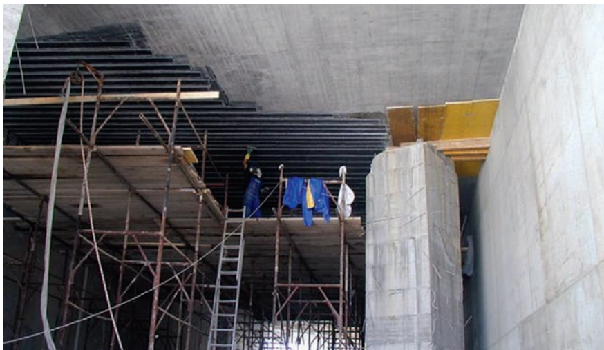
Vasúti aluljáró megerősítése Carboplate-tel – Verona, Olaszország
