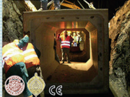
Vasúti kerethíd keretelem (1)
