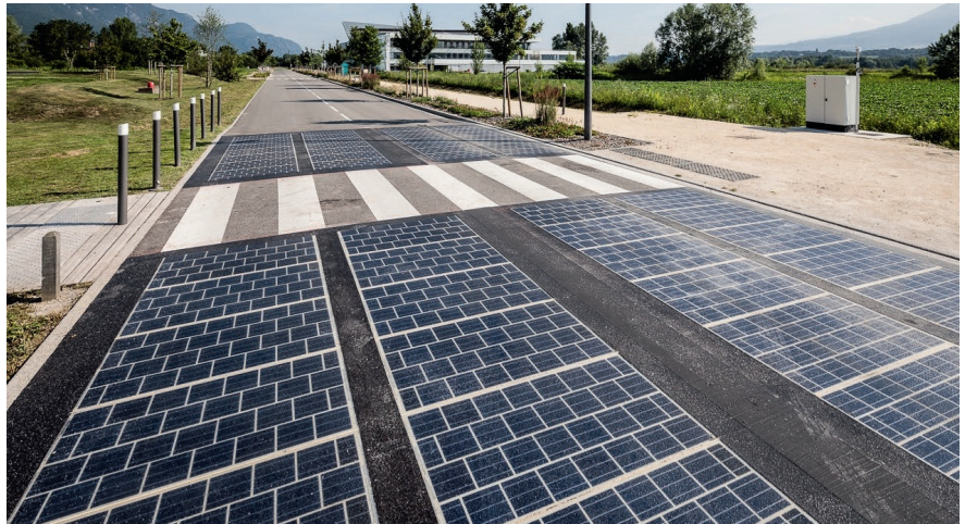
3. ábra: Wattway napfényes útburkolat (forrás: www.trendingtopics.at)
