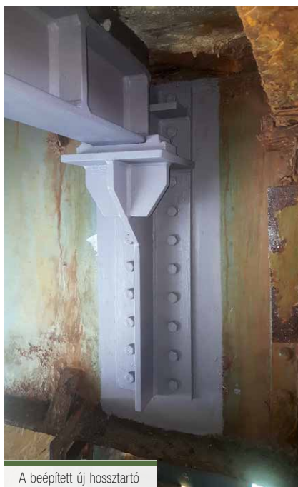
A beépített új hossztartó
