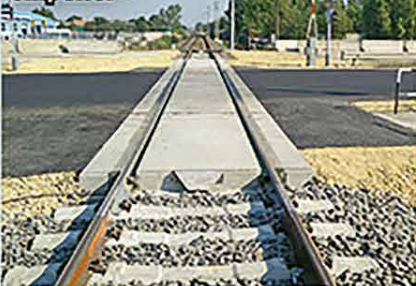
Betonacél nélküli vasúti sínpanel (1)
