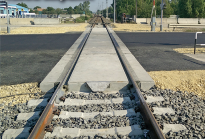
Betonacél nélküli vasúti sínpanel
