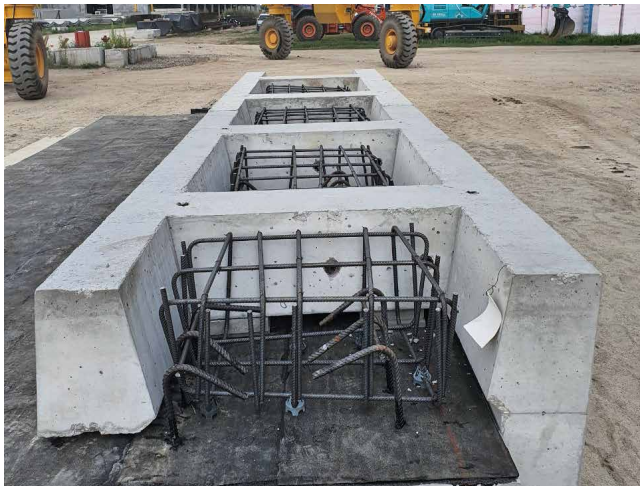
6. ábra: A hídsegély prototípuselemek a betonozás előtt
