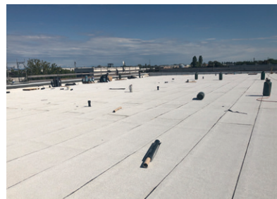
Bitumenes lapostető-szigetelés fehér színű palaörményes lemezzel
