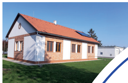
A gátörtelep főépülete a munkáspihenő épületével
