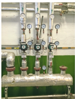
5. ábra: A 4. sz. hőközpont osztója a szekunderkört keringtetőszivattyúkkal
