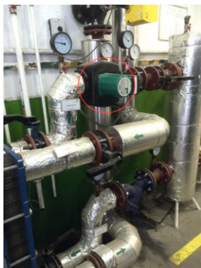
4. ábra: A hőcserélő és a hidraulikus váltó közötti szivattyú
