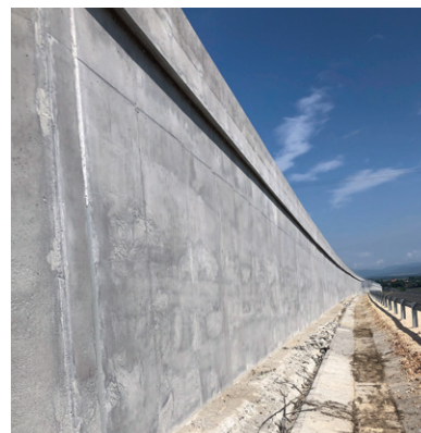
A képen az M30-as autópálya novajdrányi szakaszának támfalai láthatók, ahol 13 000 m 2 -re hordták fel a Planiseal WR 85 gél
