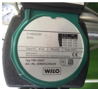
4. ábra: A hőcserélő és a hidraulikus váltó közötti szivattyú
