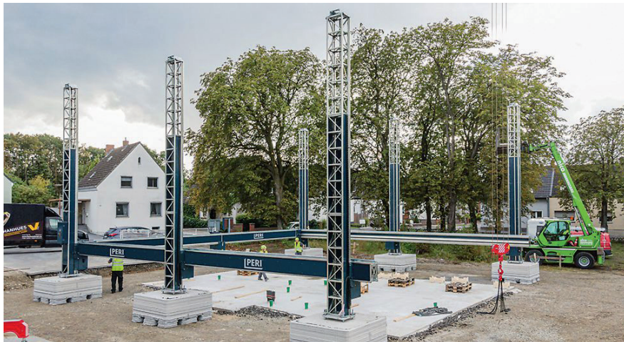
A BOD2 nyomtató a helyszínen (Forrás: PERI)
