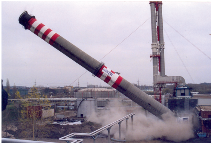
80 m magas vb. kémény robbantásos bontása a Kispesti Erőműben
