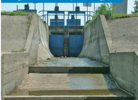
Előregyártott vízkormányzó műtárgy
