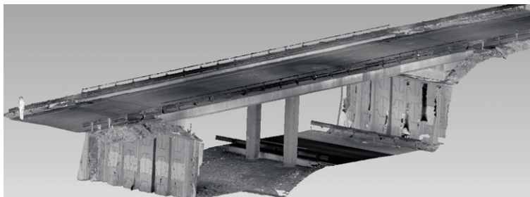
3. ábra: A kopórég drón-fotogrammetriai és hagyományos geodéziai eljárással végzett felmérése, minősítése
