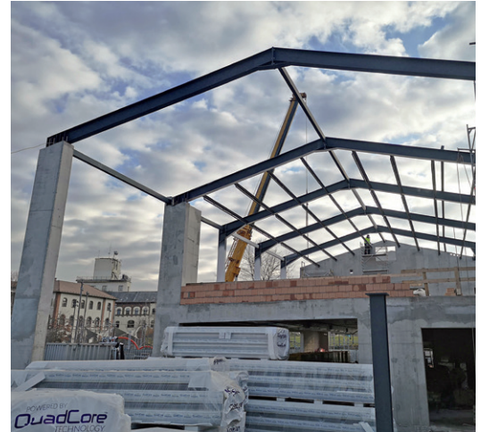
Az épülő 4. (új) csarnok
