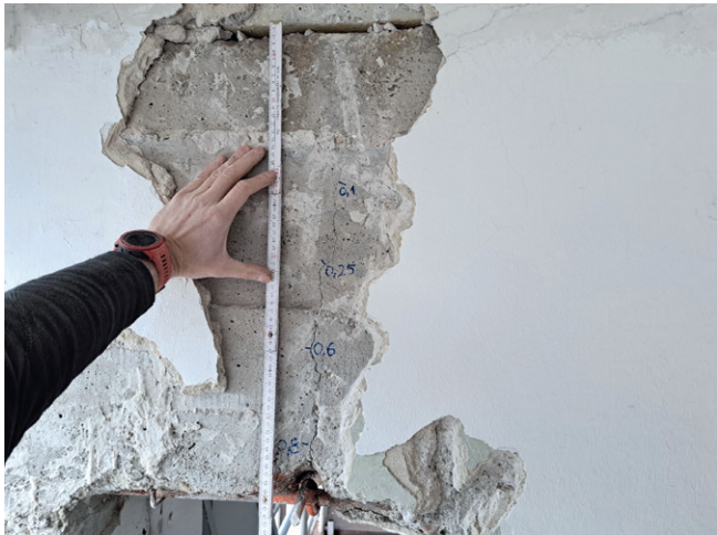
3. ábra: Keretsarok mellett kialakult markáns \sigma -repedés
