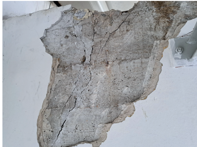
4. ábra: Közbenső oszlop mellett kialakult markáns \sigma -repedés és fellazult beton
