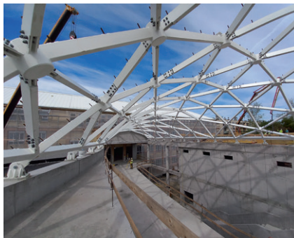
A szerelve gyártott egység a KÉSZ Ipari Gyártó Kft. üzemében, és a szerkezet a helyszínen
