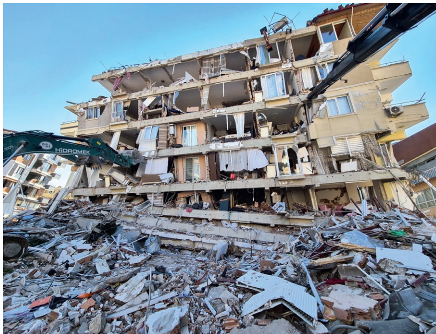
Egy részben összedőlt, megdőlt épület ideiglenes megtámasztásokkal
