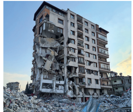
A hátra omló szomszédos épület okozta részleges romosodás
