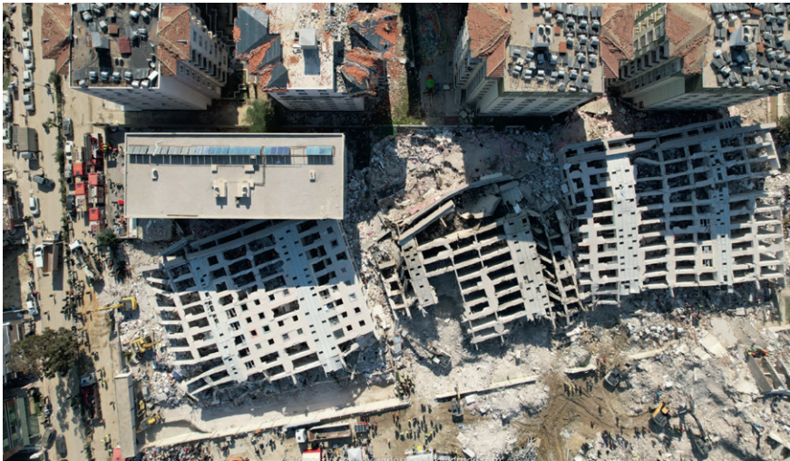
Oldalára dőlt épület Antakya-ban (Forrás: HUNOR)
