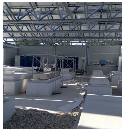
A tetőn elhelyezett napelemek, háttérben a hőszivattyú
