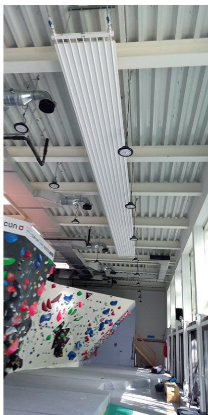
A falmászók termékének kiegészítő fűtése, meleg vizes sugárzó panellel
