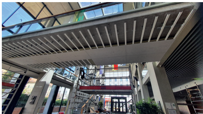
1. kép: Álmenyázat építése a híd alatt (Fotó: Semmelweis Egyetem EOK)
