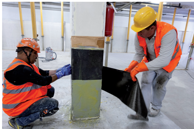
Mapewrap szövet alkalmazása
