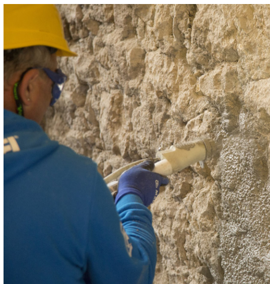
Mape-Antique Strutturale NHL alkalmazása
