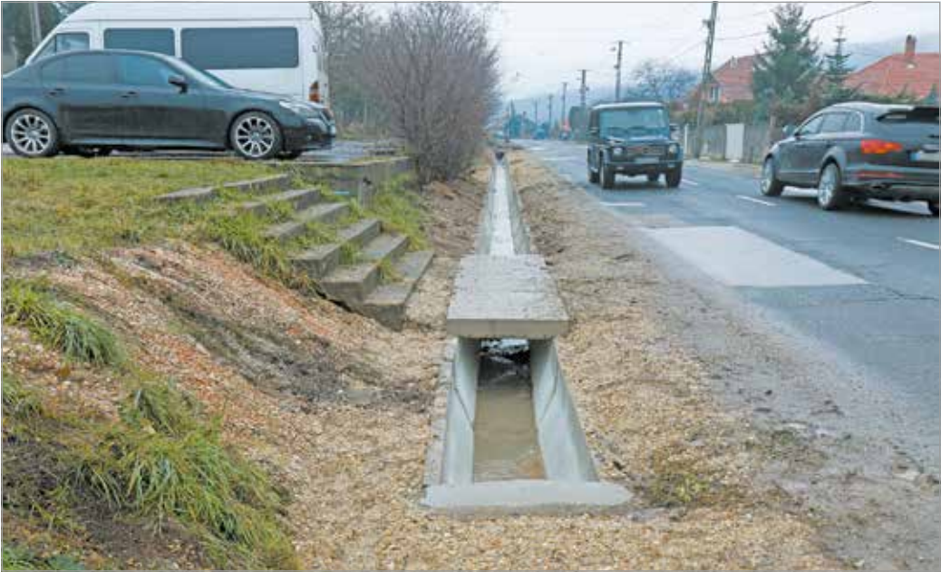
Elkészült az Erenyő utca csapadékvíz-elvezető útárokrendszerének helyreállítása is. Fotó: J.Á.
