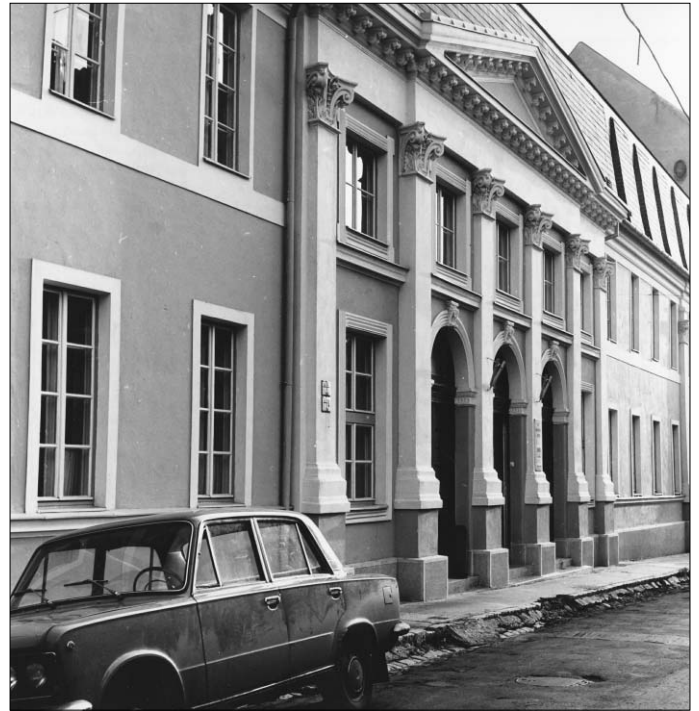
A POTE Fogászati Klinikájának épülete az 1975-ös felújítás idején
