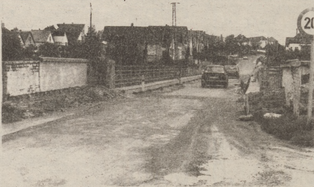
FELÚJÍTJÁK A DEÁK F. ZSILIP HÍDJÁT
