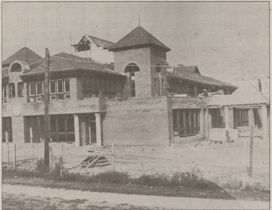
Jó ütemben halad a német oktatási központ új épületszárnyának kivitelezése Baján. Fotó: Sz. F.
