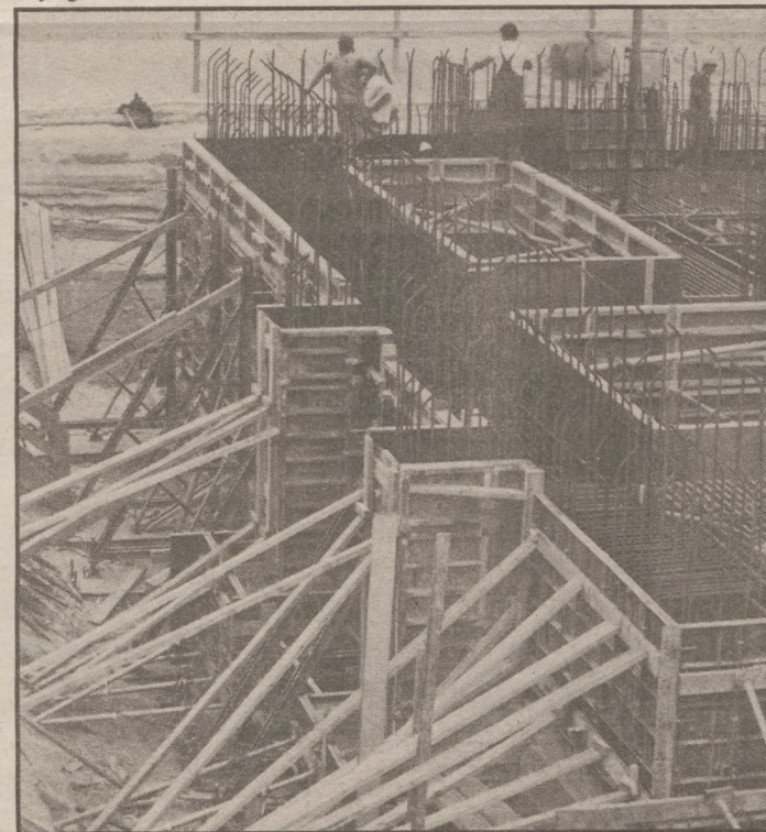
Az alaplemez készítése
