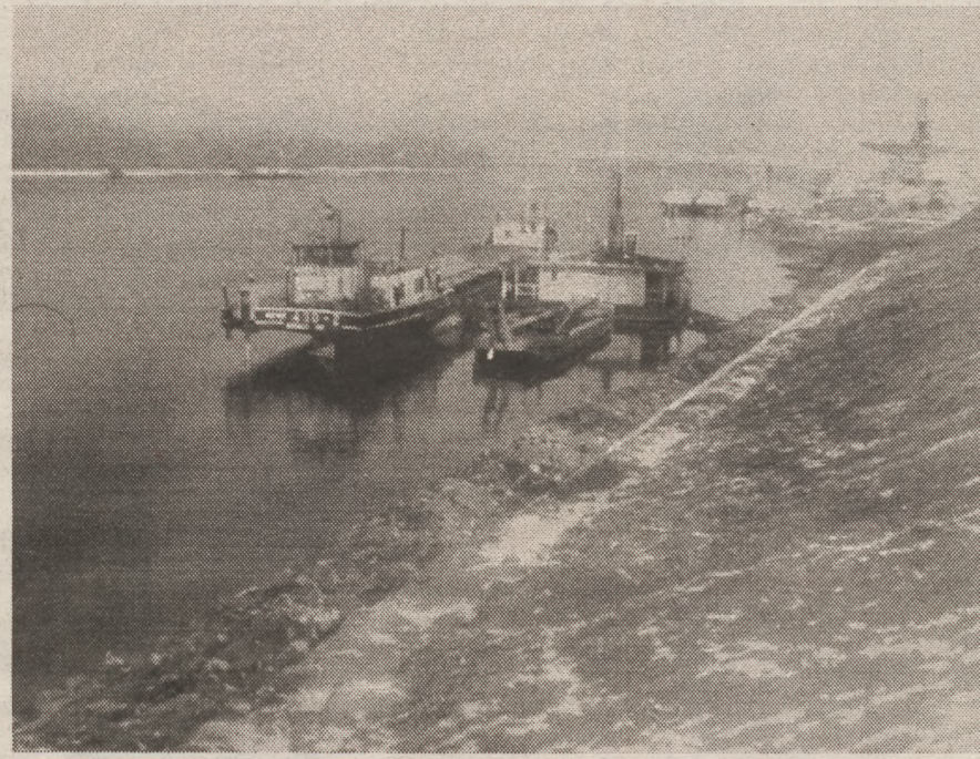
A bajai Duna-parton a Türr István kilátótól a híd felé már faragják a régi partszegélyt, alatta kövekkel erősítik a partot.
