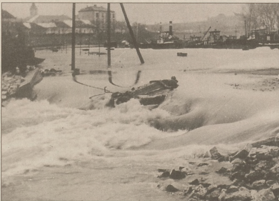
A Vöröshíd átszakadása (Baja)
