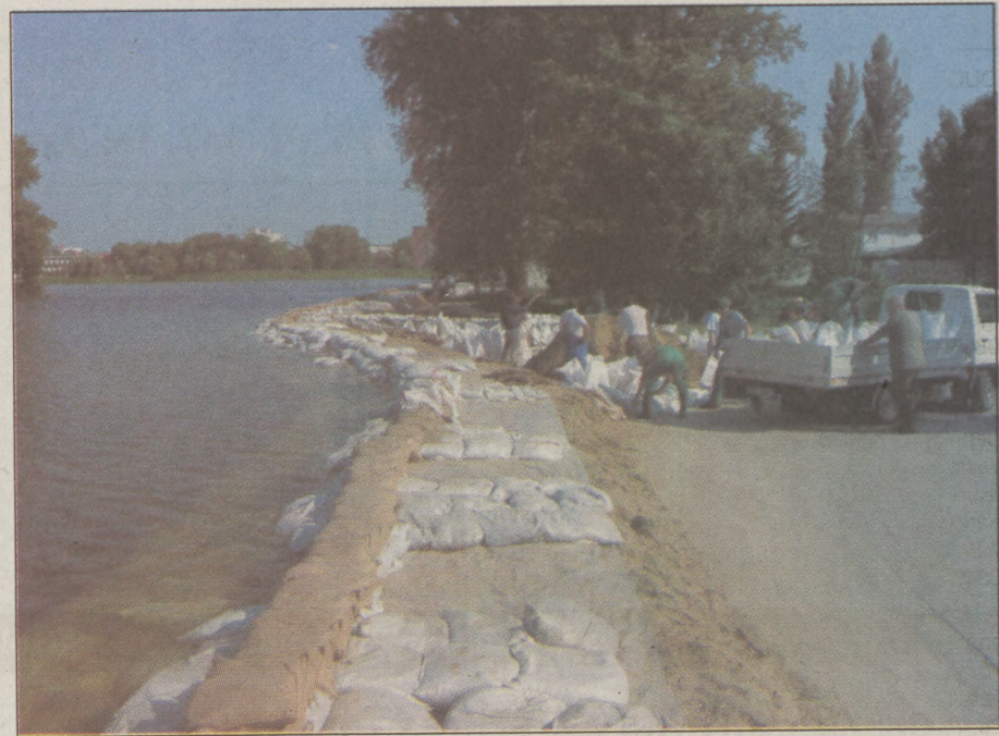
Türr átvágás Petőfi-sziget oldali védekezés
