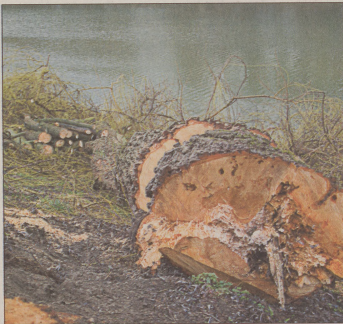
Kívülről egészségesnek tűnő, de belülről már korhadó, balesetveszélyessé vált fa
