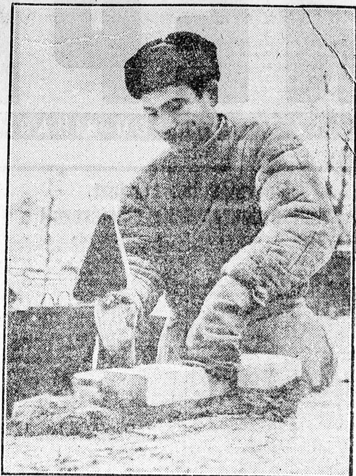
Az egész Szovjetunióban ismerik V. V. Koroljev, Sztálin-díjjal kitüntetett kőművest, aki kiváló eredményeket ért el a falazási munkák terén. Moszkva egyik építkezési vállalatának dolgozója a kiváló kőművest küldöttüknek jelölték az OSZ SZSZK Legfelső Tanácsába.
