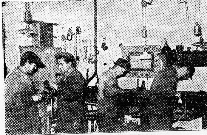
Munkában a javítóbrigád. Szabó Mihály vezetésével a stanc-gép javítását végzik.
