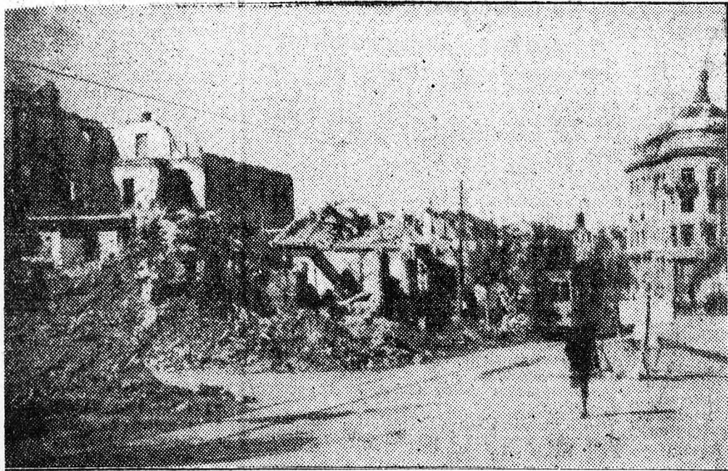
Siralmas képet nyújtott Debrecen a fasiszta hordák pusztítása után. Vigasztalan, kilátástalan volt minden. A Petőfi téri OTI bérház és a Járásbírószálg romokban hevert.
