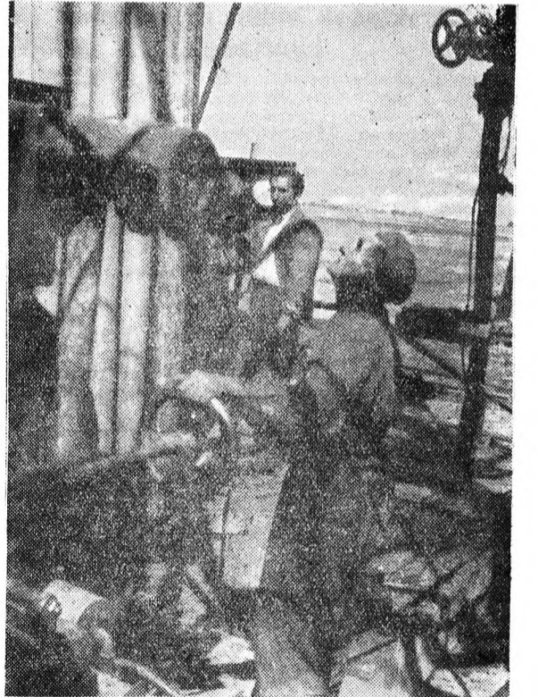
A fűrórudázat beépítését végzik a dolgozók. A képen előtérben Nagy László segédfűrómeister, a forgatóasztalon Varga Lajos kulcsos áll.
