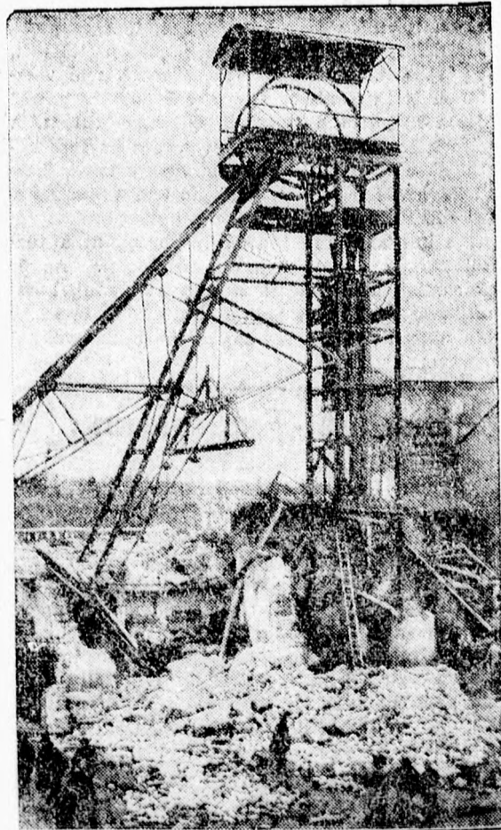
A felvonótorny az első robbanások után.
