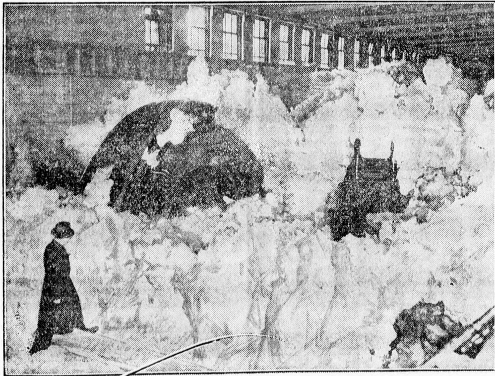
A Niagara vizesés befagyott jégtömege a Patkovizesés erőműveit is tönkretette. A víz behatolt a generátorhelyiségekbe s a jégtömeggel összetörődve, lehetetlenné tette az erőművek működését. Képünk az óriási jégtömeget mutatja.
