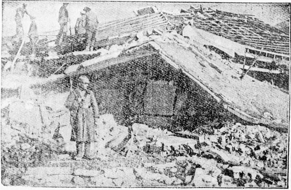
A földrengés következtében rombadőlt ház romjait igyekeznek eltakarítani.
