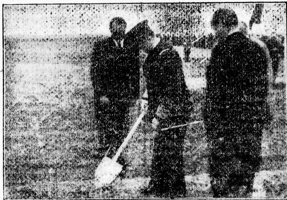
Kormányzó Urunk ásóvágásával megkezdődött a Sajo-csatorna építése.
