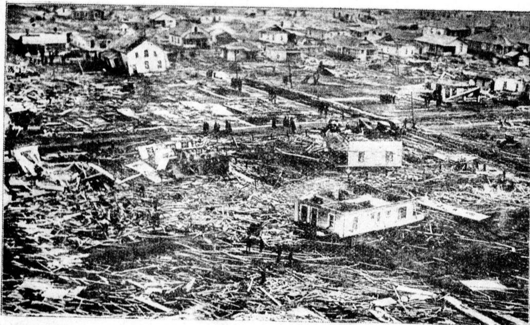
A tornado pusztítása Amerikában. A forgószél egész városokat pusztított el. Képünk egy teljesen rombadöntött észak-amerikai várost ábrázol. A hajléktalanná vált lakosok már megkezdték a törmelék eltakarítását.
